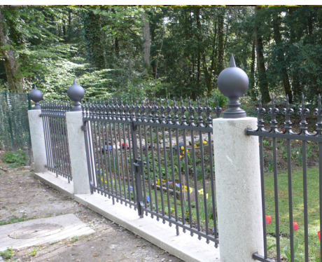
La clôture donnant sur le Chemin Vert après restauration.
