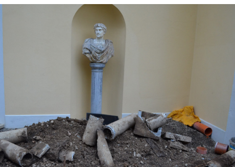
Travaux en cours. Décembre 2014.
